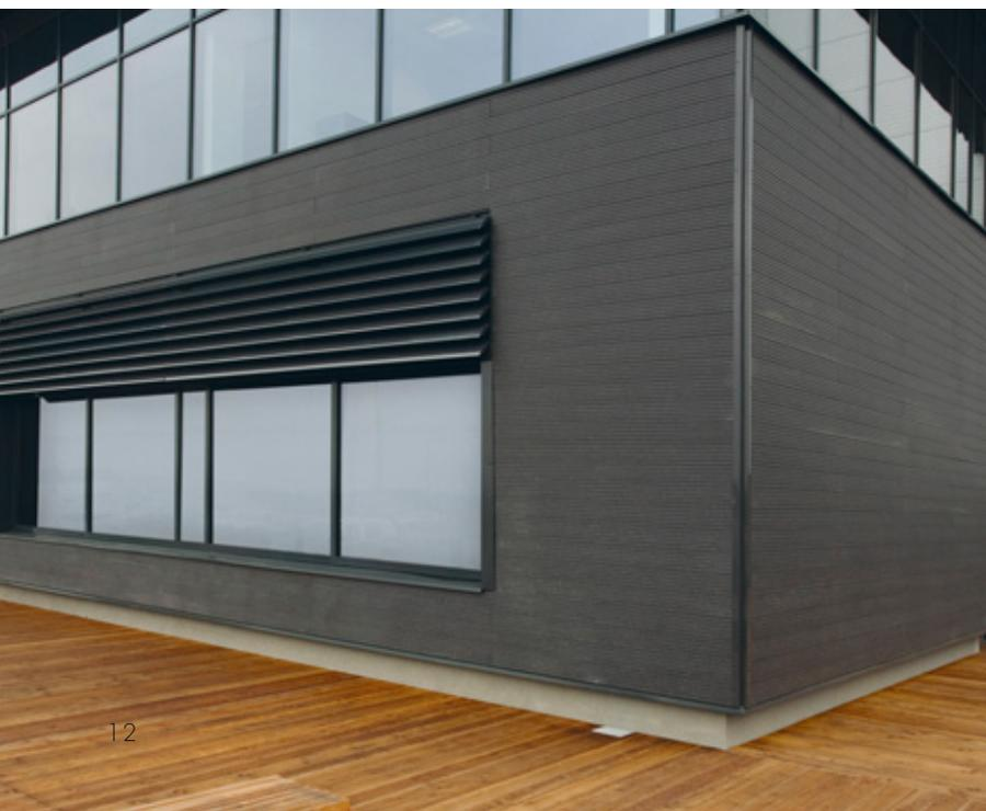
Das mühelos anzubringende System umfasst eloxierte Aluminiumprofile, die die Arbeit mit Ecken und Fugen erleichtern. Pulverbeschichtete Aluminiumprofile sind auf Bestellung erhältlich.
